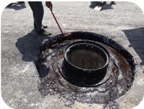
图 7.7.2-10 接触面粘层油涂刷
