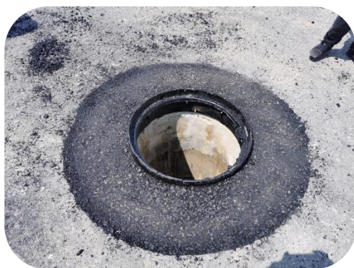
图 7.7.2-13 沥青回填后效果
