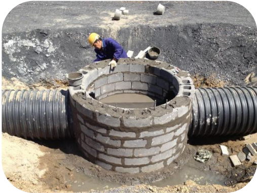
图 6.5.3-2 井室混凝土灌芯和插筋
