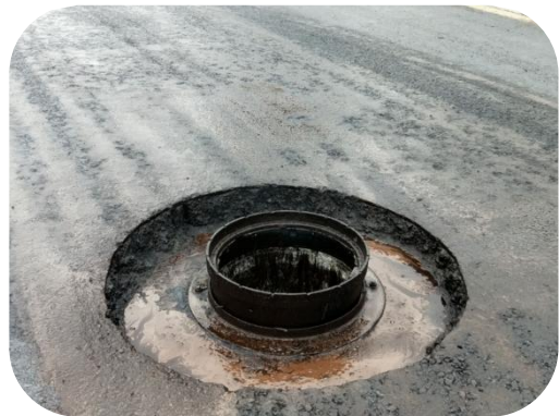
图 7.7.2-11 粘层油洒布后效果
