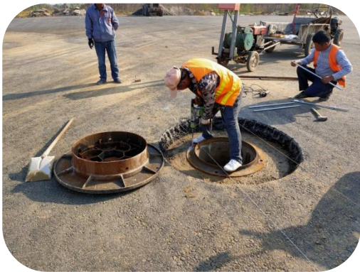
图 7.7.2-7 带线安装调节环
