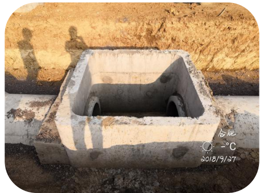
图 7.5.1-2 管口连接处包封
