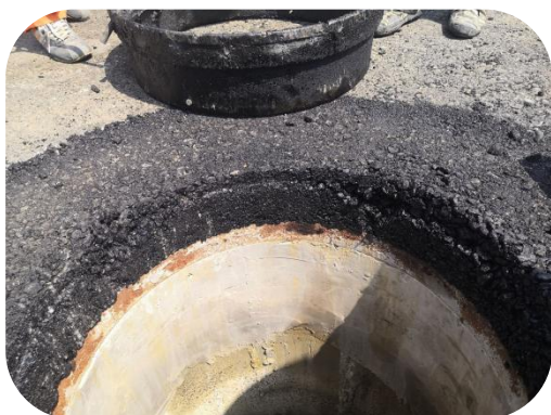
图 7.7.2-14 限位井圈拔除
