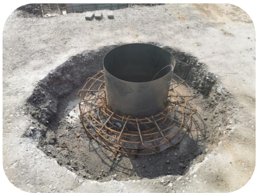
图图 7.7.1-1 井圈反挖和钢筋笼安装
