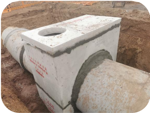
图 7.5.5-1 盖板安装和座浆
