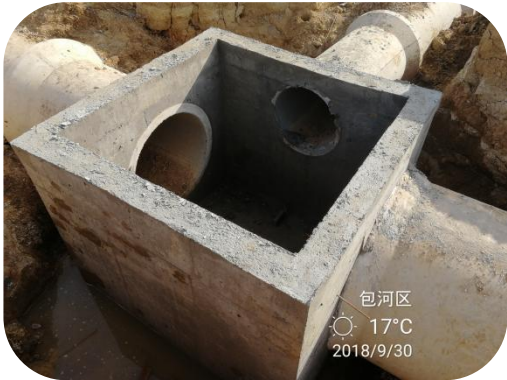
图 7.5.2-2 拆模后效果
