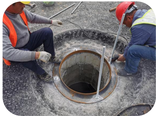
图 7.7.2-8 膨胀螺栓锚入
