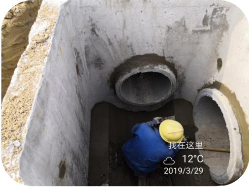
图 7.5.4-1 流水槽施工
