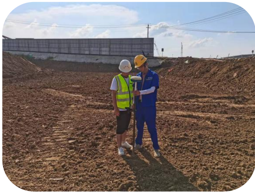
图 7.3.1 GPS 定位放样
