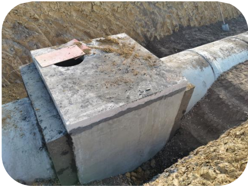
图 7.5.5-2 盖板安装和包封
