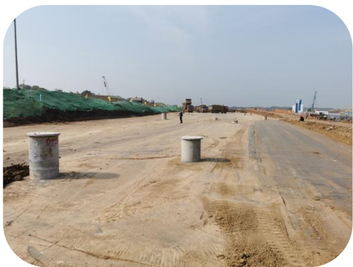
图 7.6.3-2 全段落回填后效果
