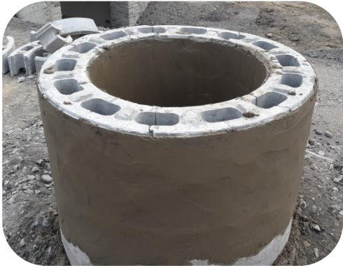
图 7.5.3-1 混凝土模块砖井筒砌筑
