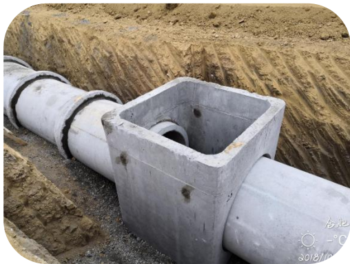
图 7.5.1-1 装配式检查井安装
