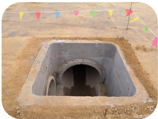
图 7.6.3-1 检查井四周灰土回填
