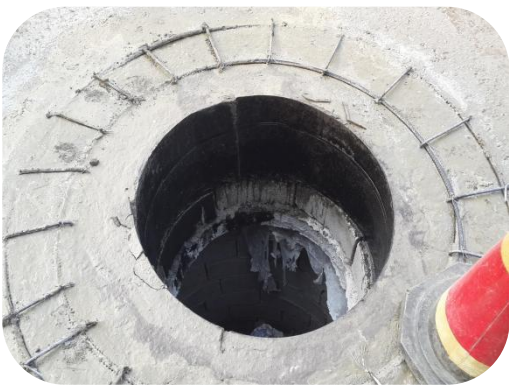
图 7.7.1-2 井圈混凝土浇筑
