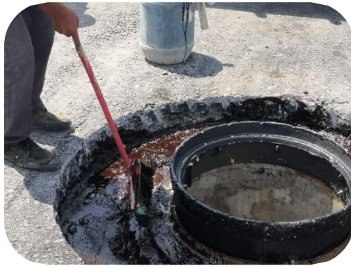
图 7.7.2-9 限位井圈涂刷防粘结剂
