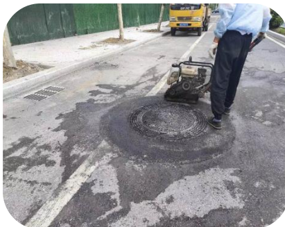
图7.7.2-26 平板夯二次处理
