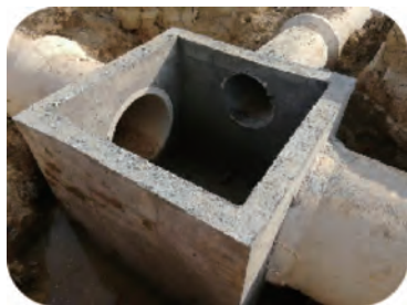
图 A.0.8 拆模后效果
