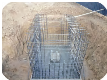
图 A.0.7 钢筋混凝土检查井浇筑
