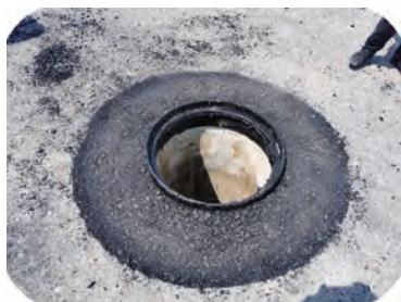
图 A. 0. 30 沥青回填后效果
