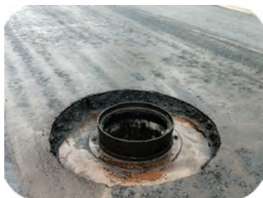
图 A. 0. 28 粘层油洒布后效果
