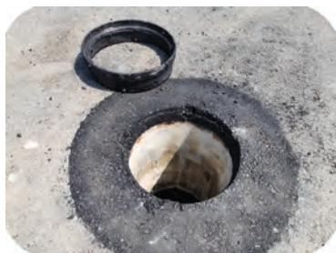
图 A. 0. 31 限位井圈拔除
