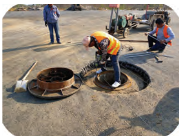
图 A.0.24 带线安装调节环
