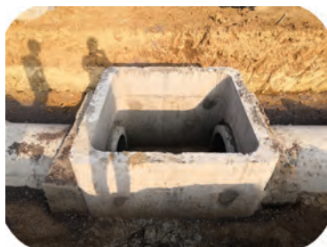
图 A.0.6 管口连接处包封
