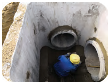
图 A.0.11 流水槽施工
