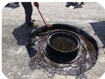
图 A.0.27 接触面粘层油涂刷
