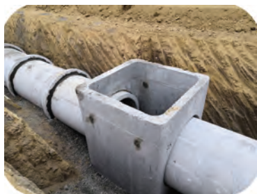
图 A.0.5 装配式检查井安装
