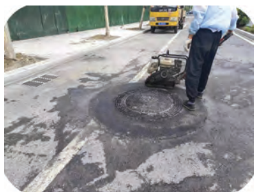
图 A.0.43 平板夯二次处理
