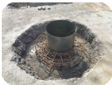
图 A.0.17 井圈反挖和钢筋笼安装
