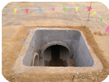
图 A.0.15 检查井四周灰土回填
