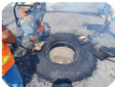
图 A. 0. 29 沥青分层回填
