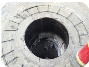
图 A.0.18 井圈混凝土浇筑
