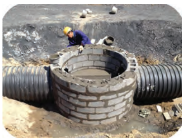
图 A.0.10 井室混凝土灌芯和插筋
