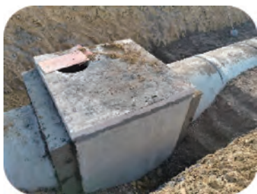
图 A.0.14 盖板安装和包封
