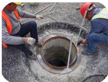
图 A.0.25 膨胀螺栓锚入
