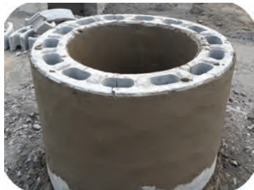
图 A.0.9 混凝土模块砖井筒砌筑
